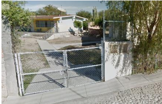
Imagen 8: Entrada Escuela primaria Vasco de Quiroga Fuente: Elaboración propia en base a trabajo de campo
