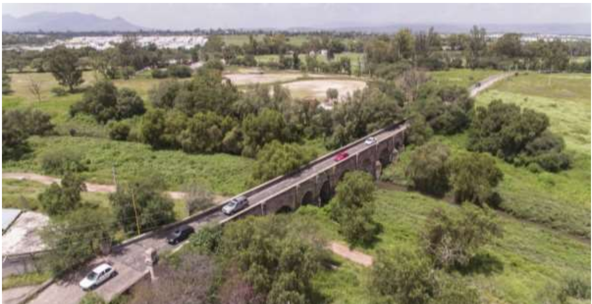
Figura 6. Vista aérea puente en Antiguo Camino a San Ignacio y el Río San Pedro
