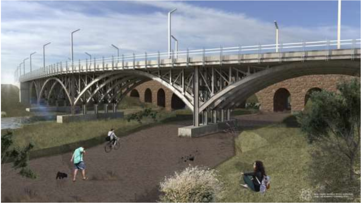
Figura 9. Armadura del Puente en el Río San Pedro y Av. Antiguo Camino a San Ignacio
