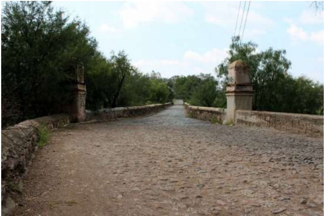
Figura 3 Ancho de calzada actual del puente sobre río San Pedro en la Av. Antiguo Camino a San Ignacio
