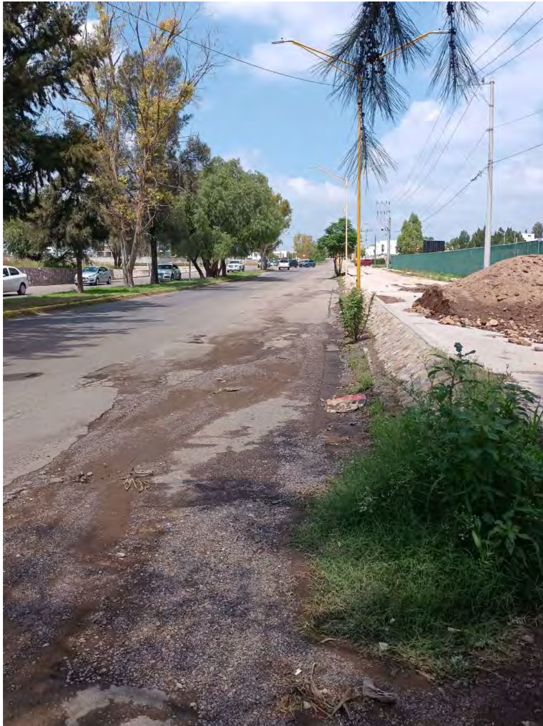
En esta imagen se puede apreciar el inicio de uno de los tramos que cuentan con calzada lateral, COORDS.: LAT. 21.909651° LONG. -102.330812°.
