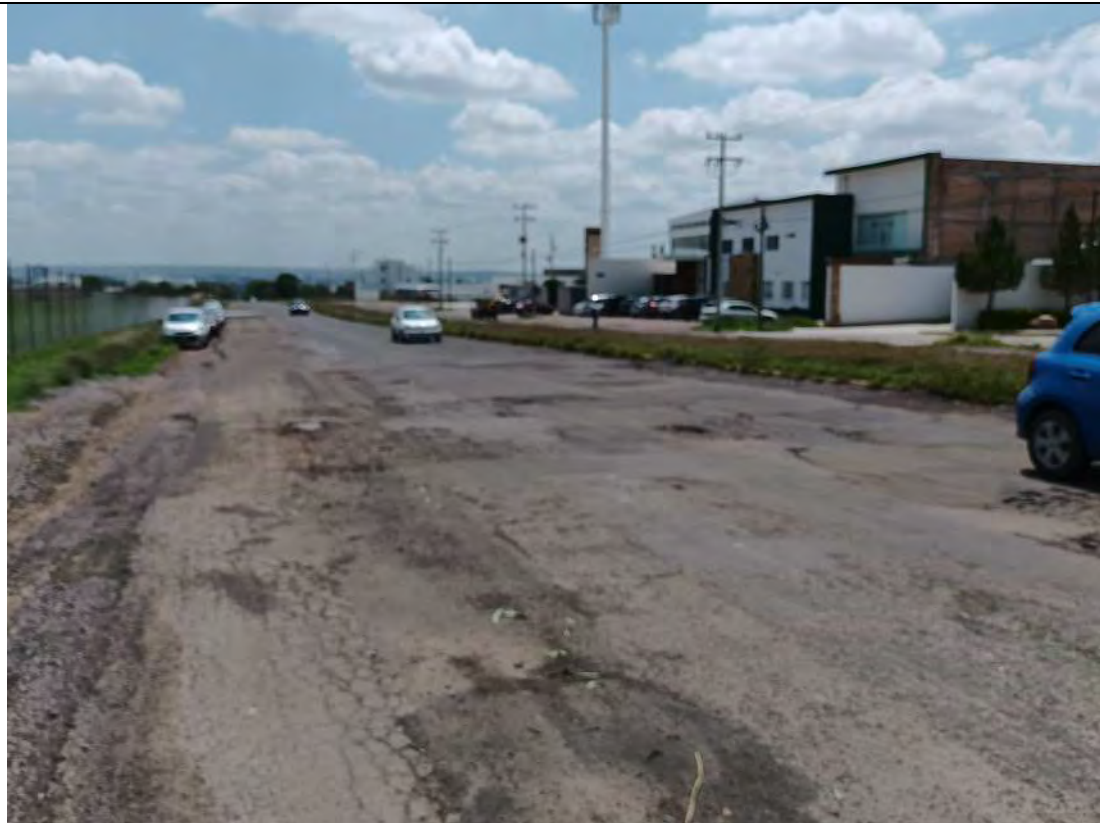
Esta es una vista hacia atrás, en donde se puede apreciar las malas condiciones del pavimento, COORDS.: LAT. 21.909159° LONG. -102.344800°.
