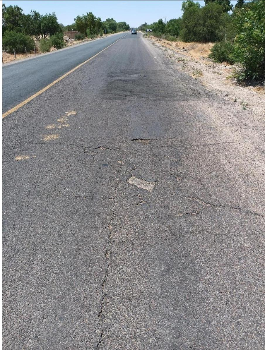
Se tienen algunos tramos cortos aislados en mal estado, en donde podrá aplicarse riego de sello o carpeta asfáltica. COORDS.: LAT. 22.228559° LONG. -102.0211190°.
