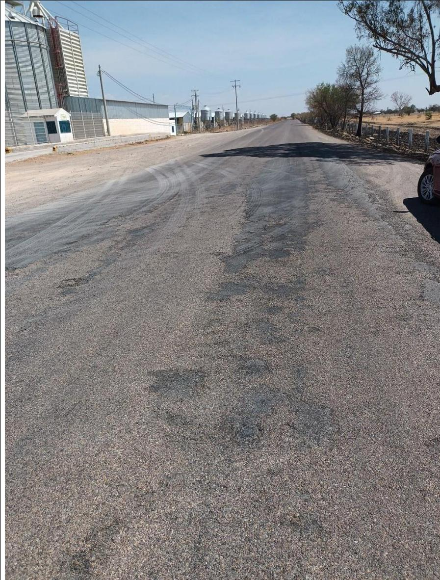
También se tienen tramos de desprendimiento de agregados de la carpeta asfáltica, así como la falta del señalamiento horizontal, por lo que se requiere mantenimiento COORDS.: LAT. 21.809857° LONG. -102.096936°.
