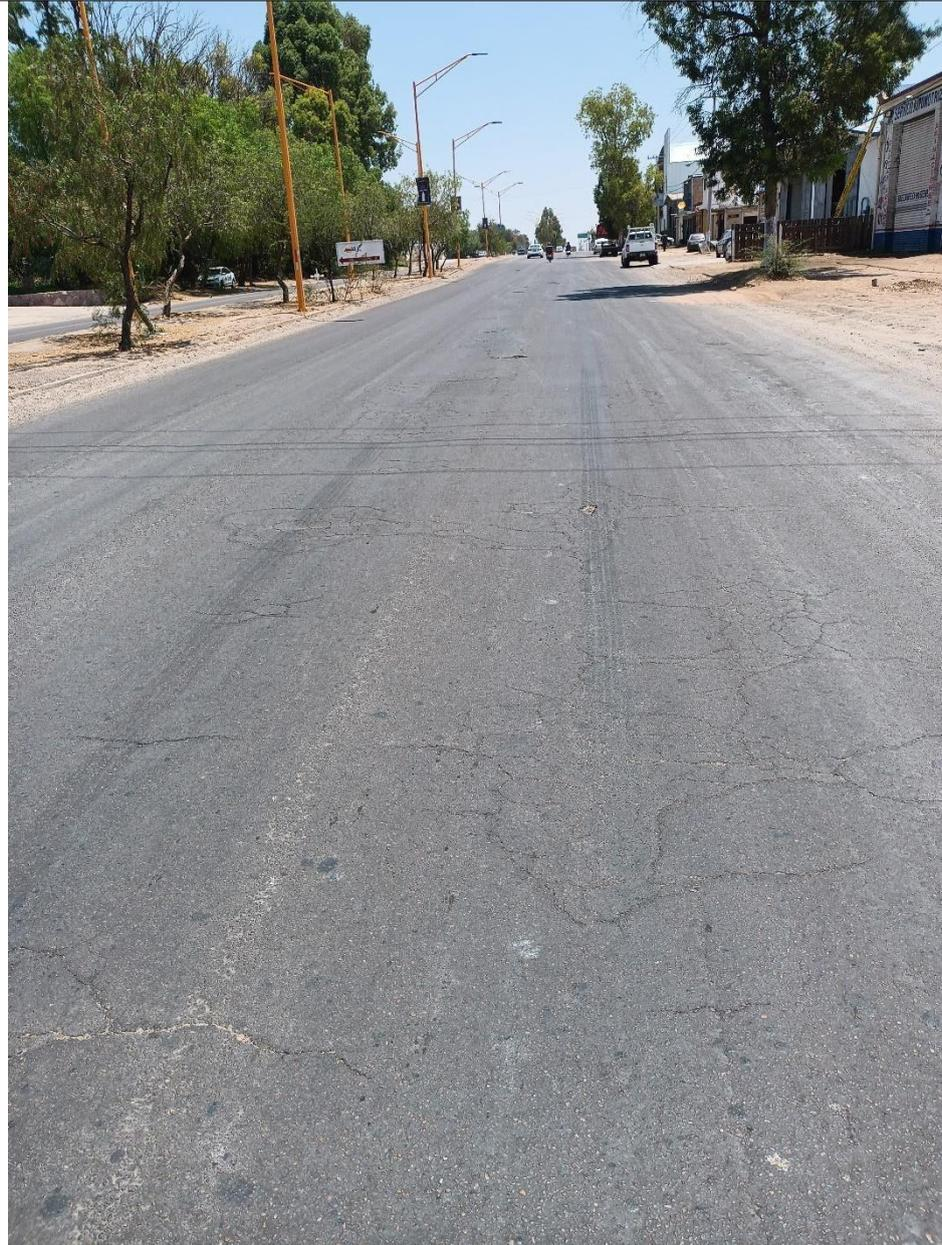
Se tienen algunos tramos cortos aislados en mal estado, en donde podrá aplicarse riego de sello o carpeta asfáltica. COORDS.: LAT. 21.982785° LONG. -102.336689°.
