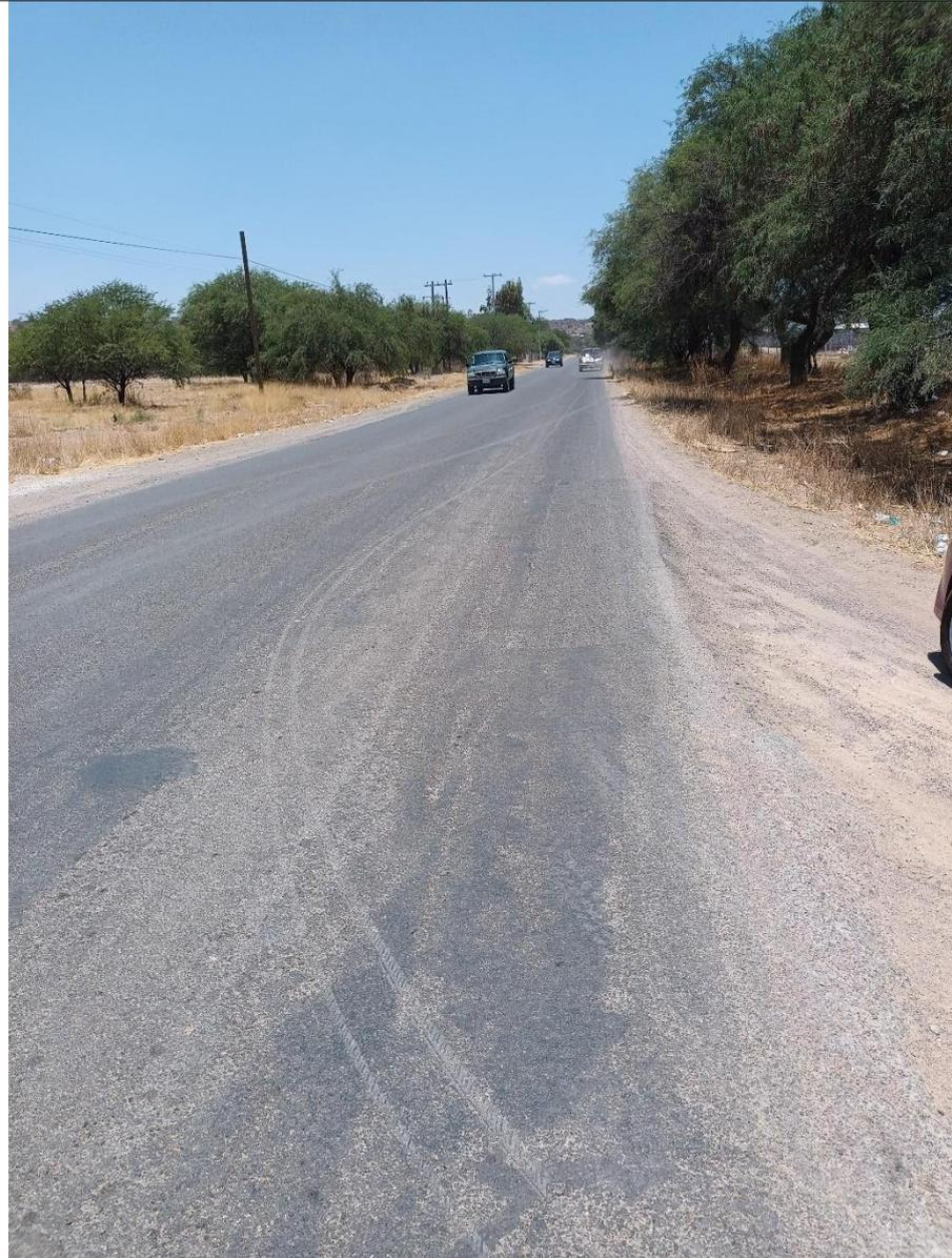
Se observa falta del señalamiento horizontal que el pavimento ya se ha estado bachando, por lo que hay que estarlo monitoreando sobre todo en la próxima temporada de lluvias, COORDS.: LAT. 22.243476° LONG. -102.325340°.
