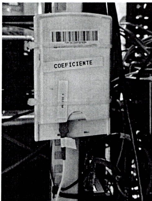
Imagen 8. Roseta de distribución donde se remata la fibra óptica instalada.
